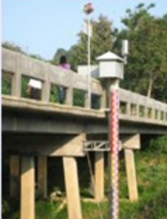
สถานีเตือนภัยด้วย ปลิวภาวน้ำฝนและระดับน้ำ
